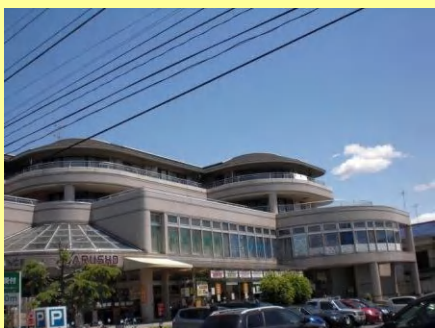
建物北側外観
