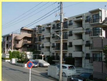
建物北側外観
